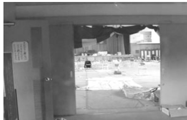
卒業式が行われた体育館、当時のままの期限りきで人気がない。
